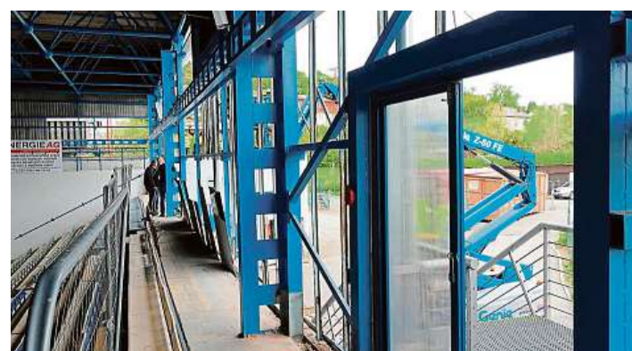
Úspora Stavaři už rozebrali část haly, kterou čeká zateplení. Mají tím klesnout náklady na chlazení ledové plochy. Foto: město Vimperk
