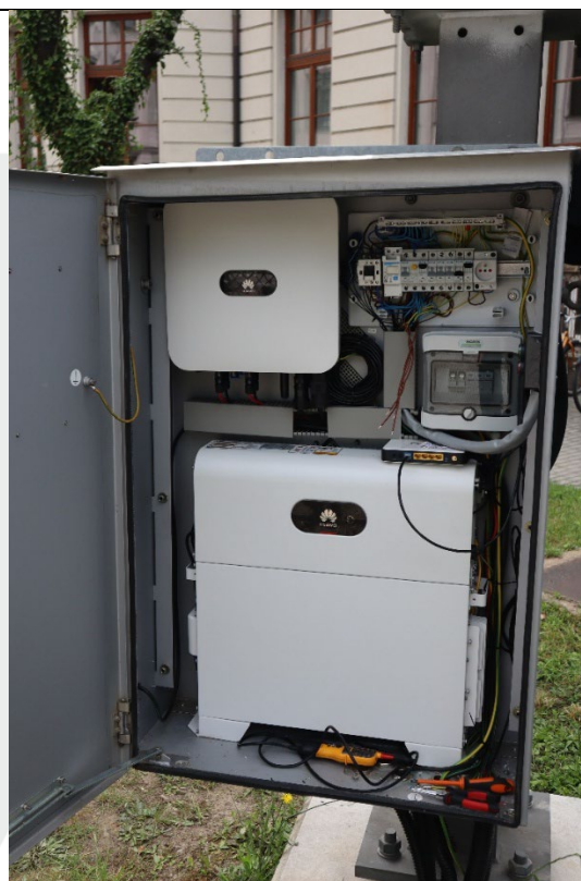
Obrázek 49 - Veřejná dobíjecí stanice
