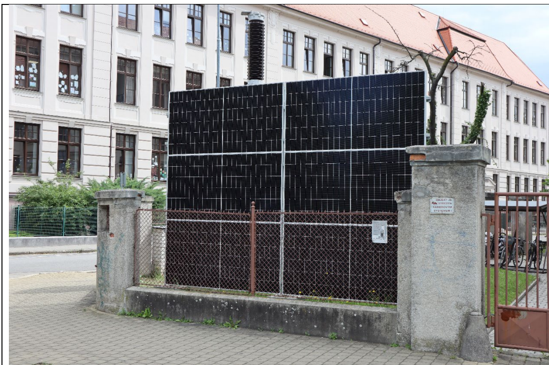
Obrázek 47 - Veřejná dobíjecí stanice
